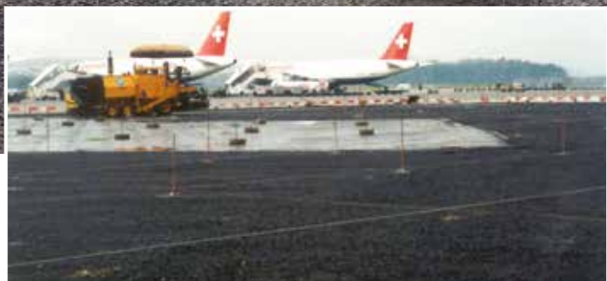
9. Il rinforzo della pista dell'aeroporto di Zurigo (Svizzera) con rete in fibra di carbonio
