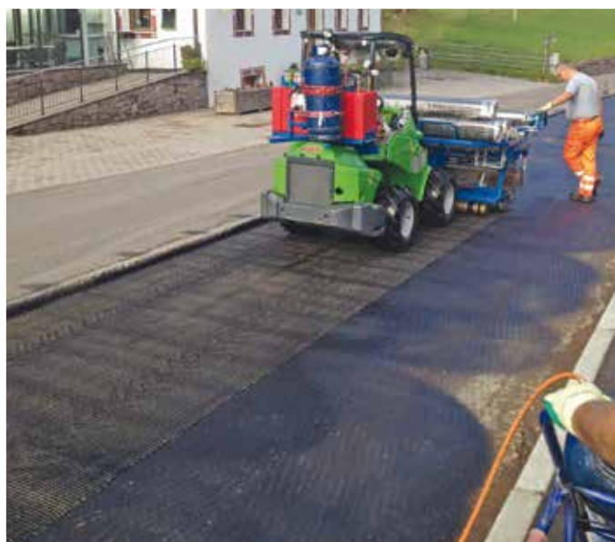
1. Un esempio della posa della rete S&P
