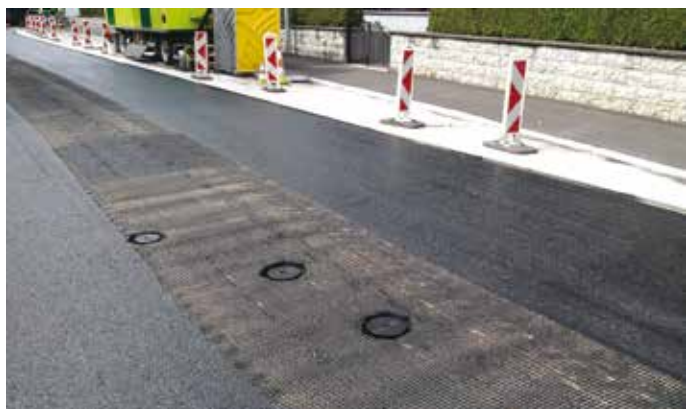
10. Il rinforzo della pavimentazione con rete in fibra di carbonio in prossimità dei lavori di posa di infrastrutture (fibra ottica) con tecnica Trencher a Schwyz (Svizzera)
