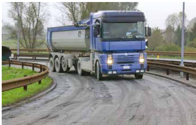
12. Il rinforzo strutturale dello svincolo di Campogalliano (MO) con rete in fibra di carbonio sulla A22 Autostrada del Brennero
