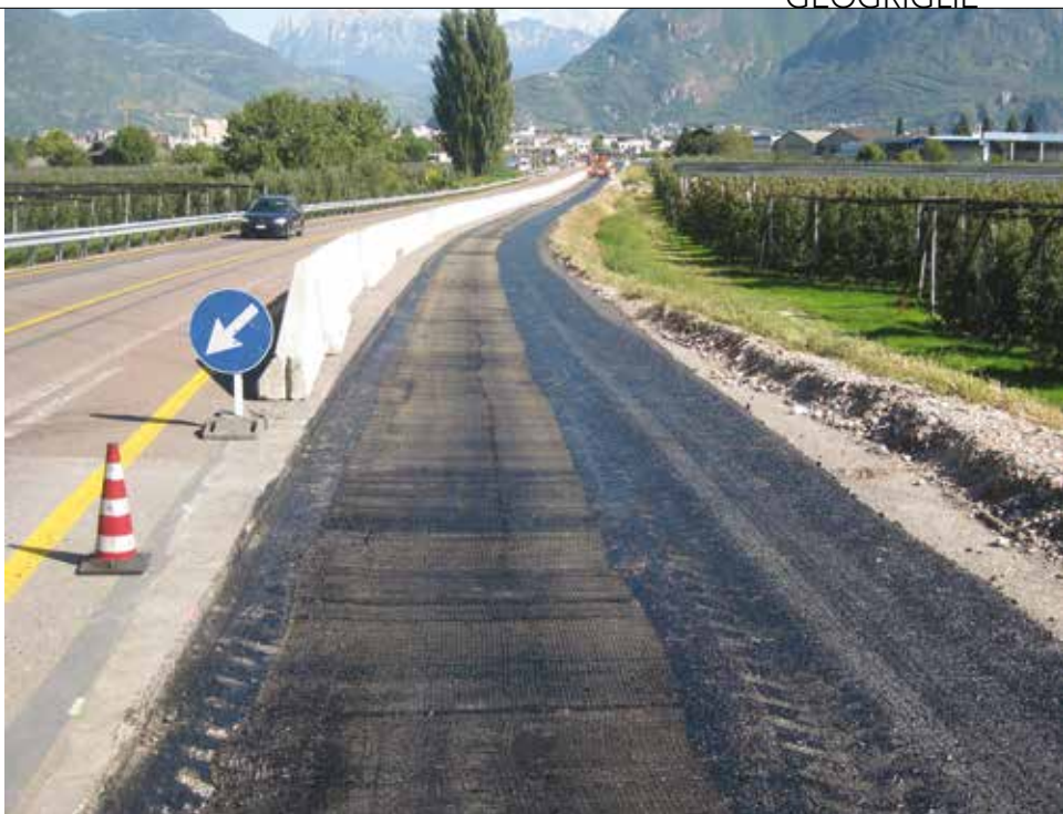
7. Una rete di rinforzo in fibra di carbonio utilizzata come armatura di ripresa tra la corsia esistente e quella nuova per l'allargamento della corsia Metrobus ad Appiano (BZ)
