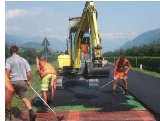
2. Stesa strato sottile di c.b. con escavatore
