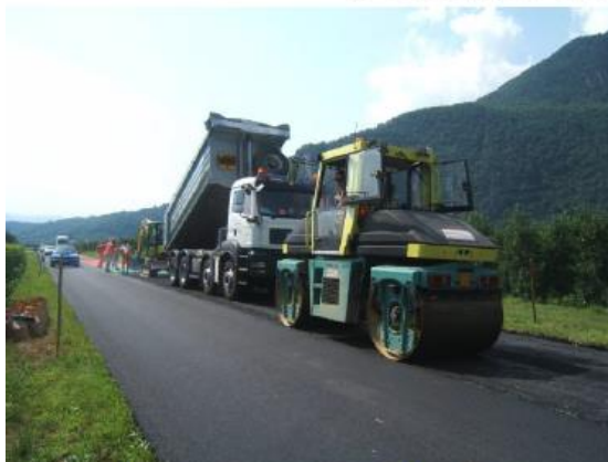
3. Rullatura strato sottile c.b.
