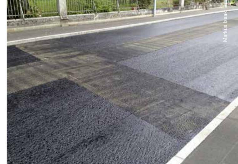
Etappierungen beeinträchtigen die Homogenität des Strassenaufbaus. Mit Carbon-Taping können die Inhomogenitäten abgedeckt werden.
