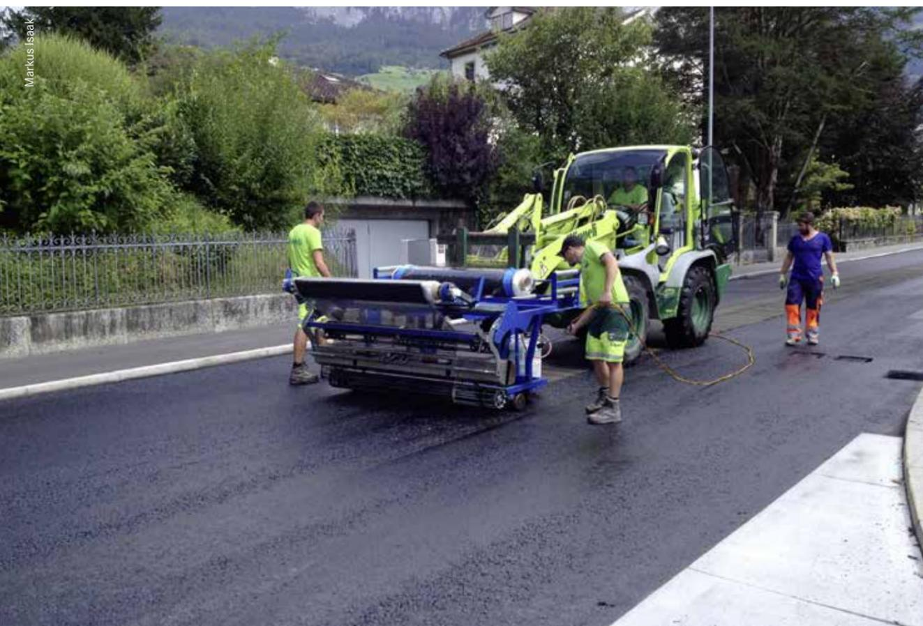
Bahnhofstrasse in Schwyz: Die Asphaltbewehrung wird mit einem Abrollgerät eingebaut.
