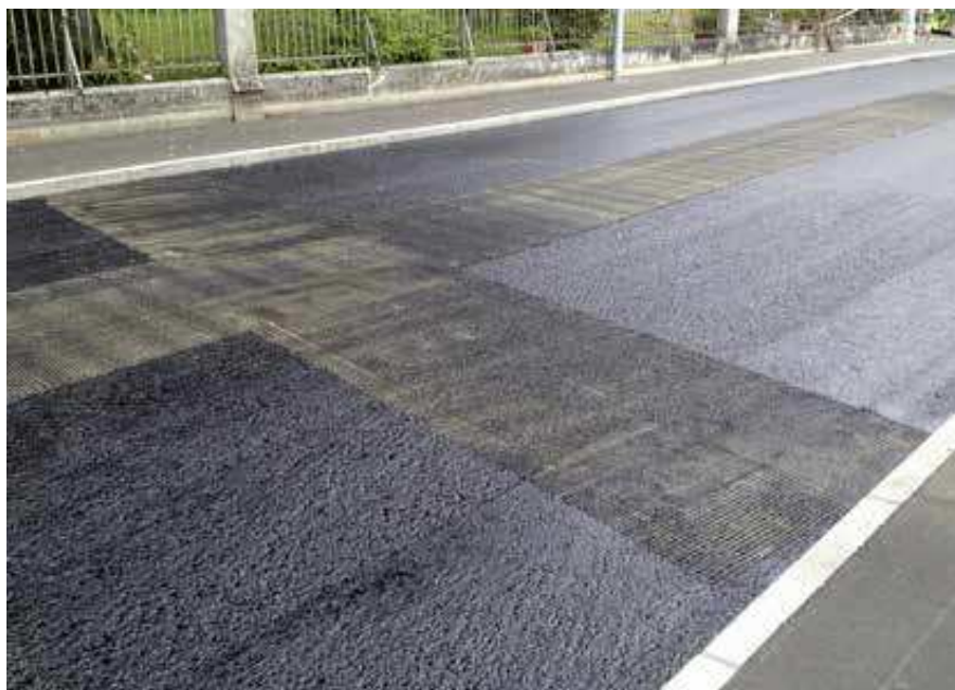
La suddivisione in fasi di lavoro pregiudica l'omogeneità della pavimentazione stradale. Il Carbon-taping rende uniformi zone non omogenee.
