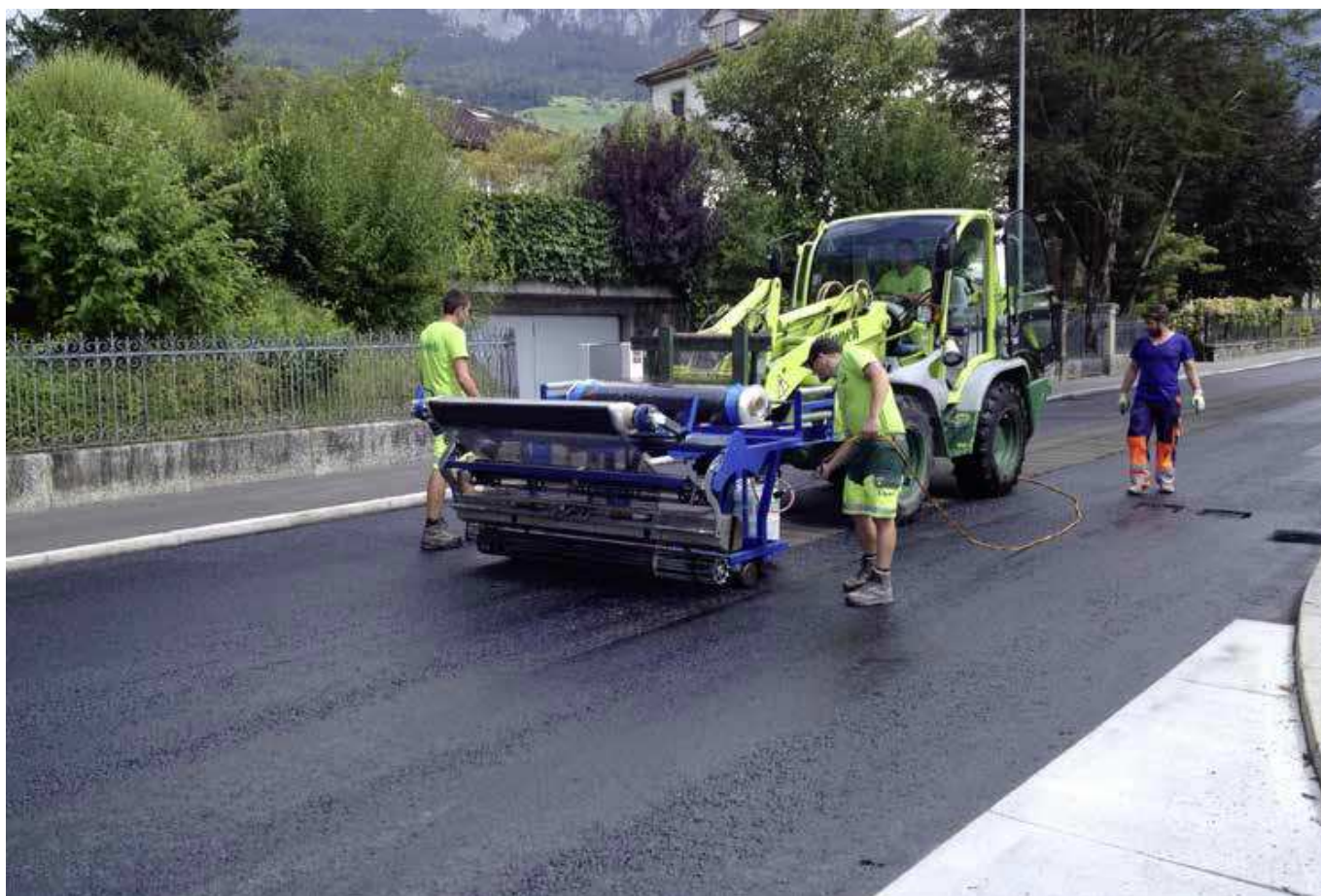
Bahnhofstrasse a Schwyz: l'armatura è posta in opera con l'apposito dispositivo.
