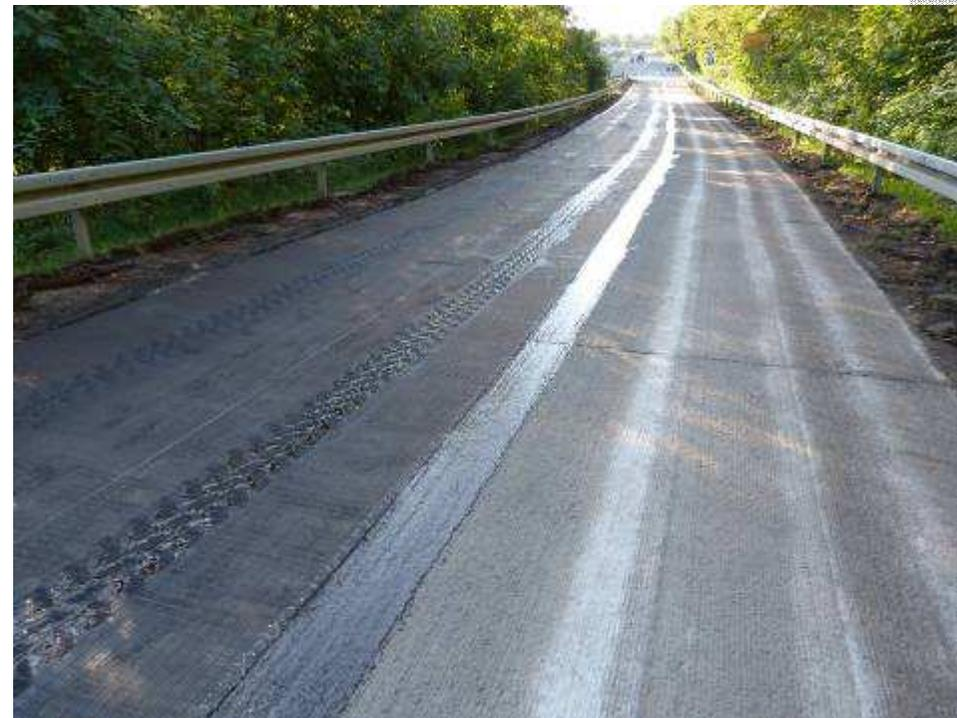
Deutlich verzögerte Rissfortpflanzung, da das Bewehrungsgitter die Spannung aufnimmt und verteilt.
