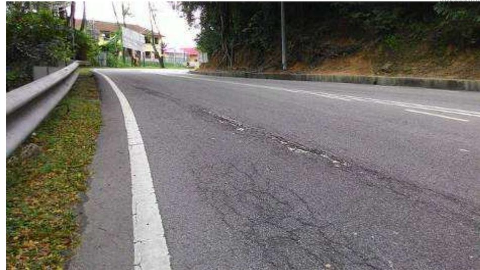
Asphaltbewehrung: **Ja/ (Nein)**, Verzögerung des Durchschlagens der Fugen / Verzögerung der Rissbildung aufgrund unterschiedlichen des Setzungsverhaltens
