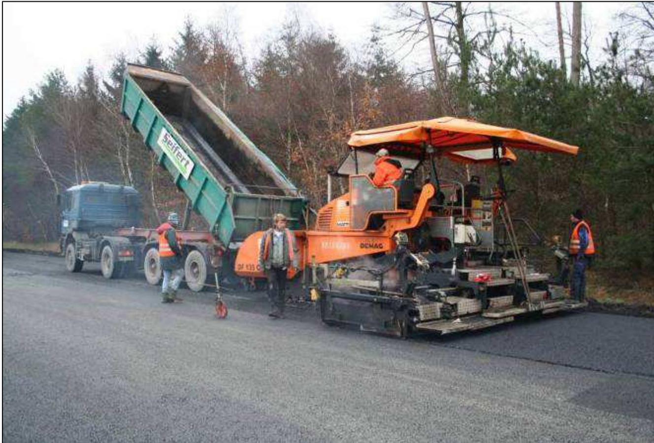
Beim Mischguteinbau muss die Asphalteinlage trocken sein.
